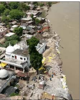
गांव को बचाने के लिए नदी किनारे पत्थर बिछाए जा रहे हैं। मस्जिद का एक हिस्सा नदी के ऊपर हवा में लटक रहा है
