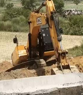
स्लैब को बुलडोजर और क्रेन की मदद से हटाया गया। फिर इसके नीचे दबे मजदूरों को बाहर निकाला गया।
