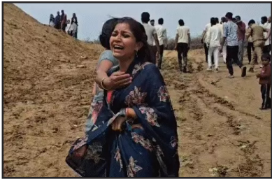
पुल हमीरपुर जिले में बेतवा नदी पर बन रहा था। तड़के जब हादसा हुआ, उस वक़्त कुछ मजदूर ऊपर काम कर रहे थे, जबकि कुछ पुल के नीचे सो रहे थे।
