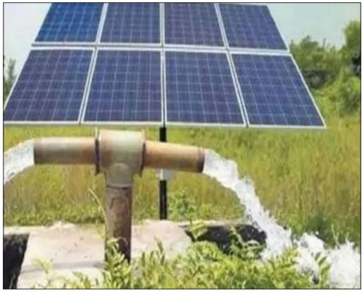
प्रत्येक वाटर पंप पर एक हजार लीटर क्षमता की टंकी स्थापित की जाएगी। सौर ऊर्जा से संचालित यह प्रणाली 150 फीट गहराई तक बोरिंग के माध्यम से पानी उपलब्ध कराएगी।
