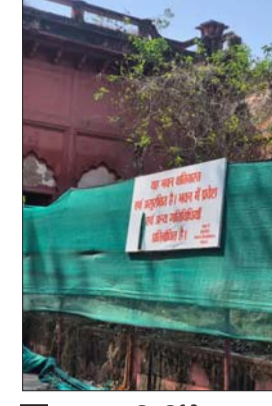
लखनऊ यूनिवर्सिटी प्रशासन ने भवन के जर्जर होने का बोर्ड लगा रखा है
