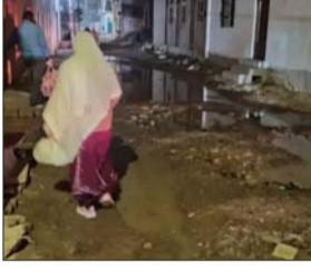
पाइपलाइन में लीकेज के कारण सड़क पर पानी भर जाता है।
